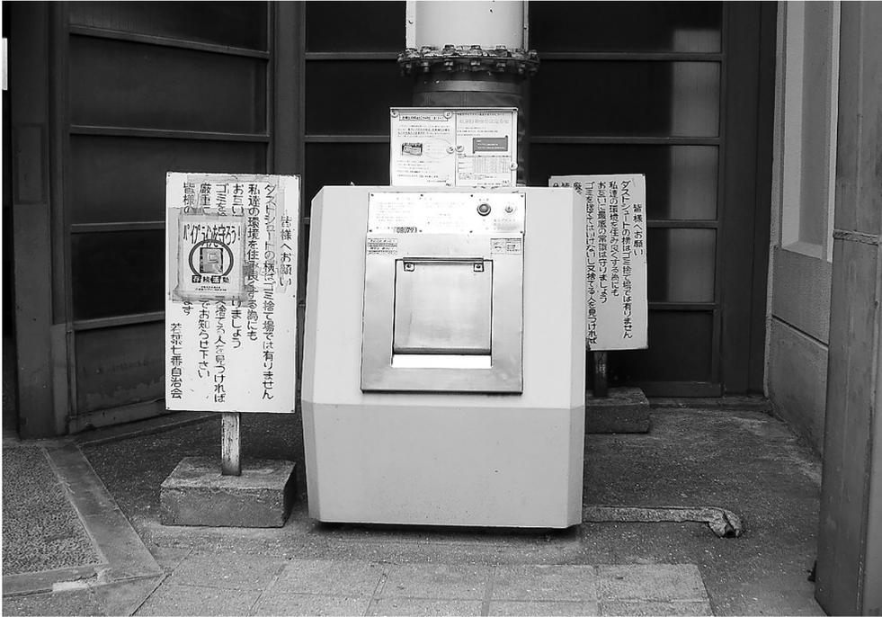
写真9 パイプライン採用芦屋市県営住宅1階の可燃ごみ投入口
