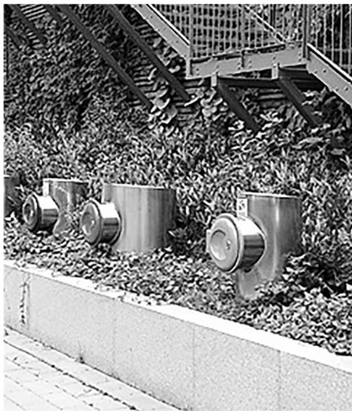
写真16 スウェーデン人工エコシティのハンマビーショースタッドのパイプライン投入口
