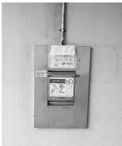
写真8 パイプライン採用芦屋市県営住宅3階の可燃ごみ投入口
